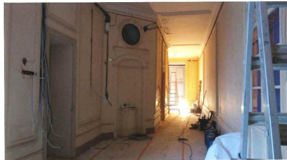
Le couloir des chambres, pendant les travaux (Photo Ooidonk)
