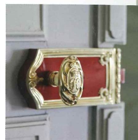
▲ Slot van de deur van het rotundesalon, opnieuw gelakt en verguld (Foto Ooidonk)
